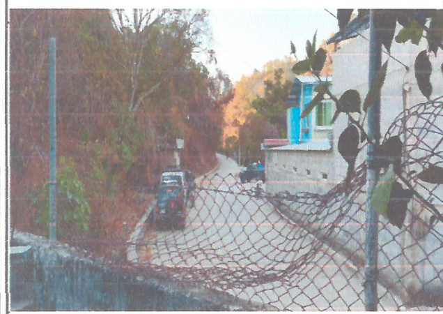
Foto 3: MANTENIMIENTO DE MURO PERIMETRAL.
