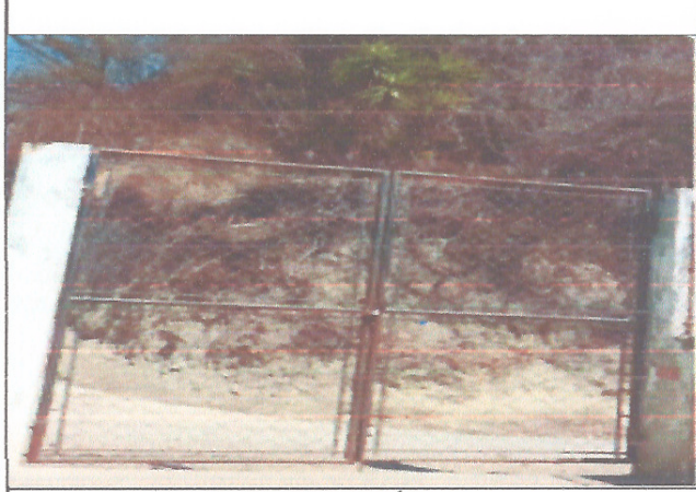
Foto 4: MANTENIMIENTO DE PORTÓN
