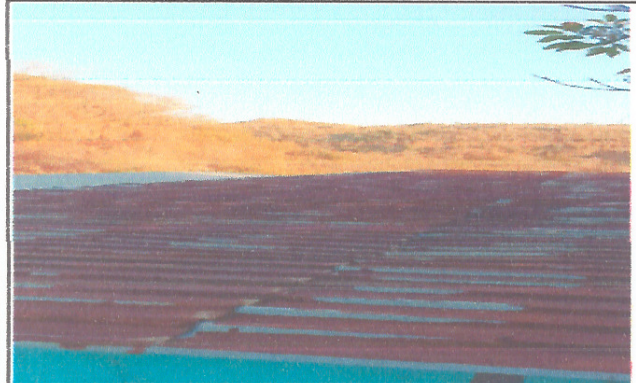
Foto 1: MANTENIMIENTO DE CUBIERTA DE LAMINA.
