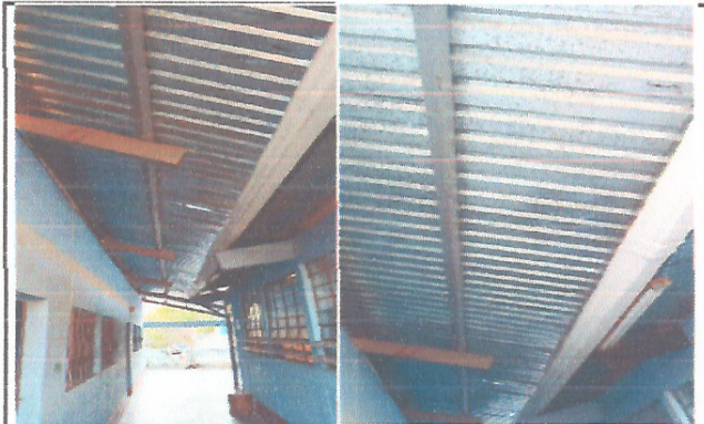
Foto 2: MANTENIMIENTO DE CUBIERTA DE LAMINA.
